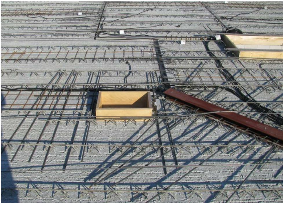
*Abbildung 9: Deckenauslässe und Verkabelung in der Filigrandecke*
