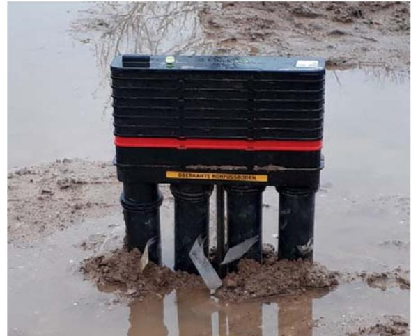
Abbildung 2: Mehrspartenhausanschluss vor Herstellung der Betonsohle
