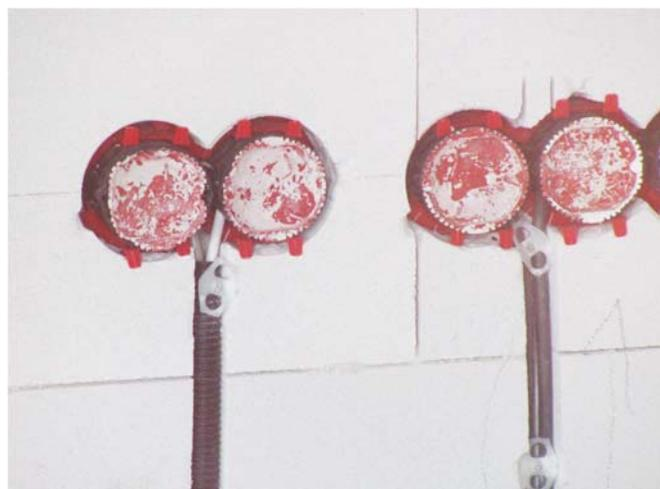
Abbildung 12: Schutzrohr für Koaxialkabel
