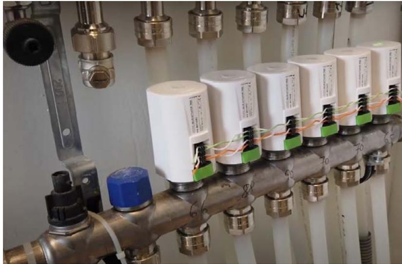
Abbildung 10: Stellantriebe für Fußbodenheizungen
