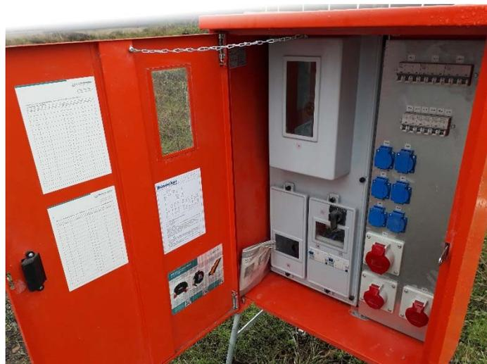
Abbildung 14: Baustromverteilerschrank nach VDE
